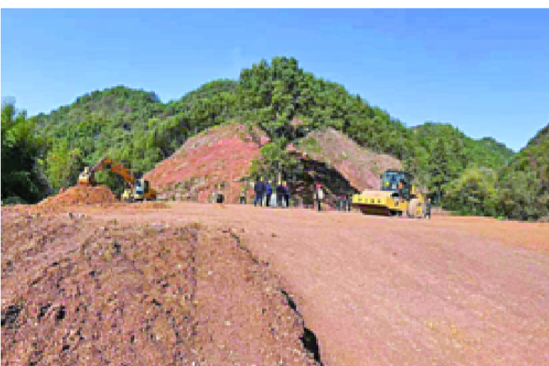
建设中的351国道
